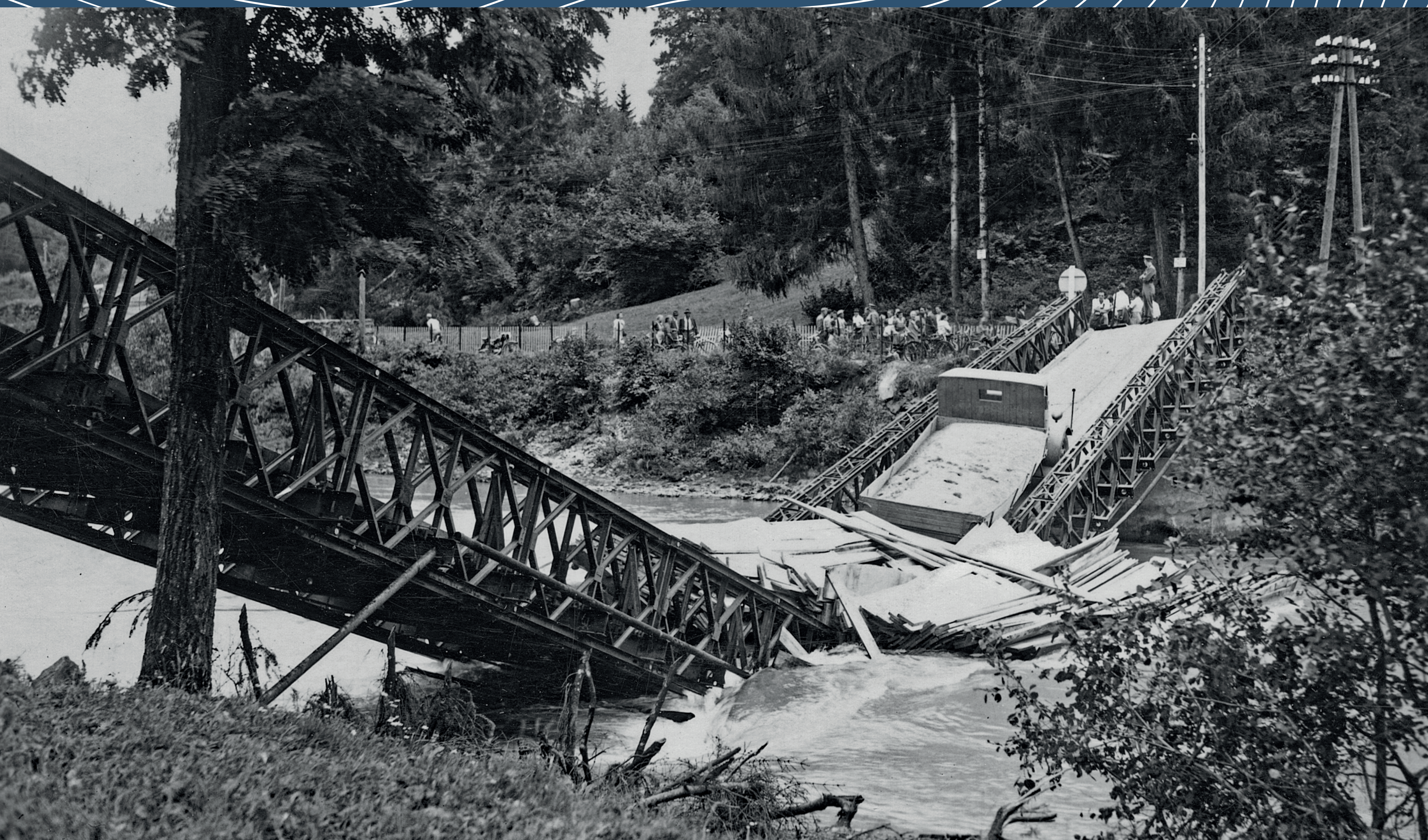
▲ Die auf 14 Tonnen zugelassene Schlossbrücke hält dem 35-Tonnen-Lärchenbrettertransport am 27. August 1951 (natürlich) nicht stand. Fotograf: Unbekannt; Sammlung Walter Geir – TAP
