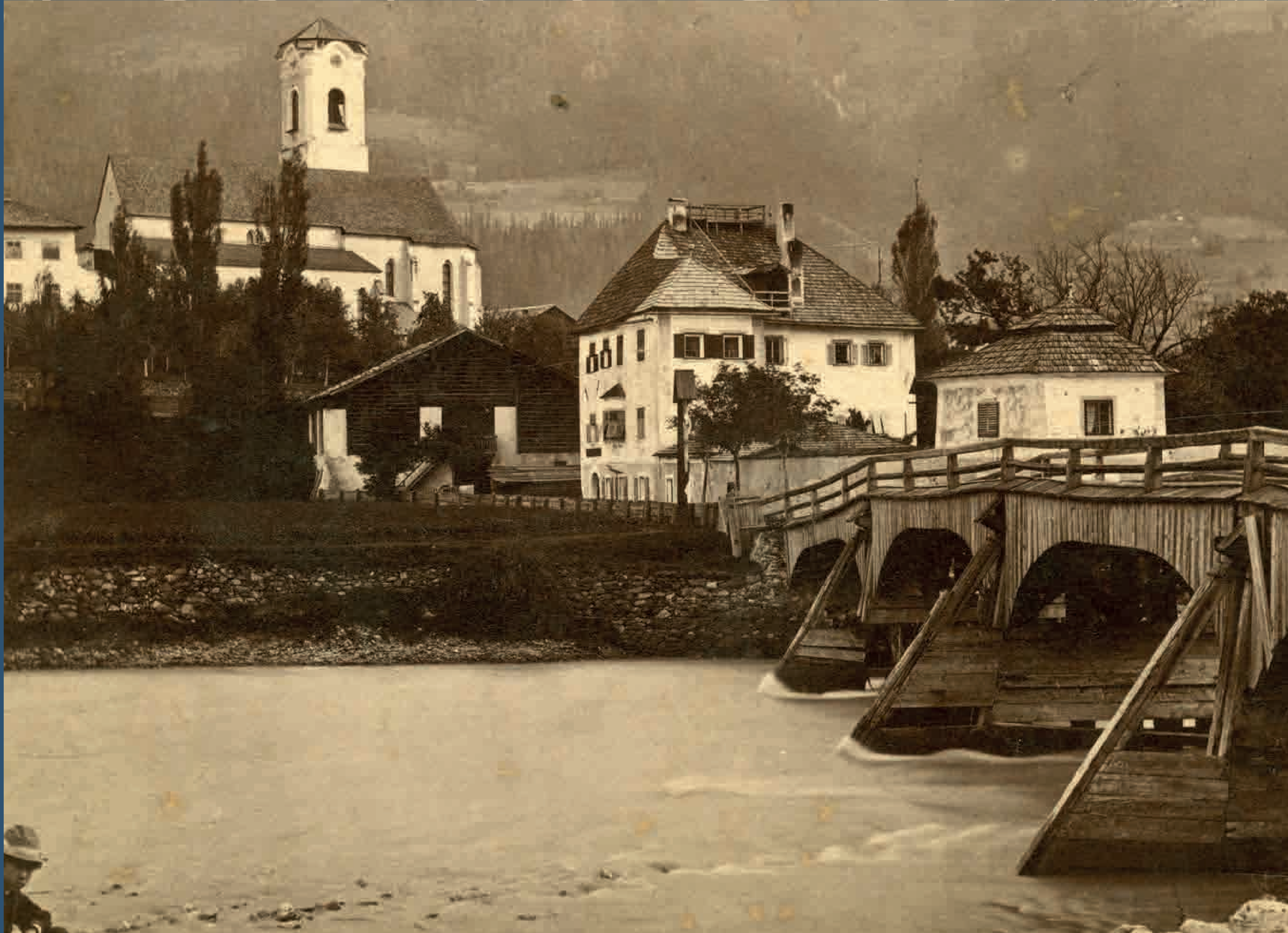
▲ Ein klassisches Ensemble für die Fotografie, um 1895: die hölzerne Pfarrbrücke über die Isel, der Gasthof „Glöcklturn“ und die Pfarrkirche St. Andrä mit dem (bis 1909) noch flachen Turmdach aus der Barockzeit. Fotograf: Johann Reiner, Sammlung Maria Kecht – TAP
