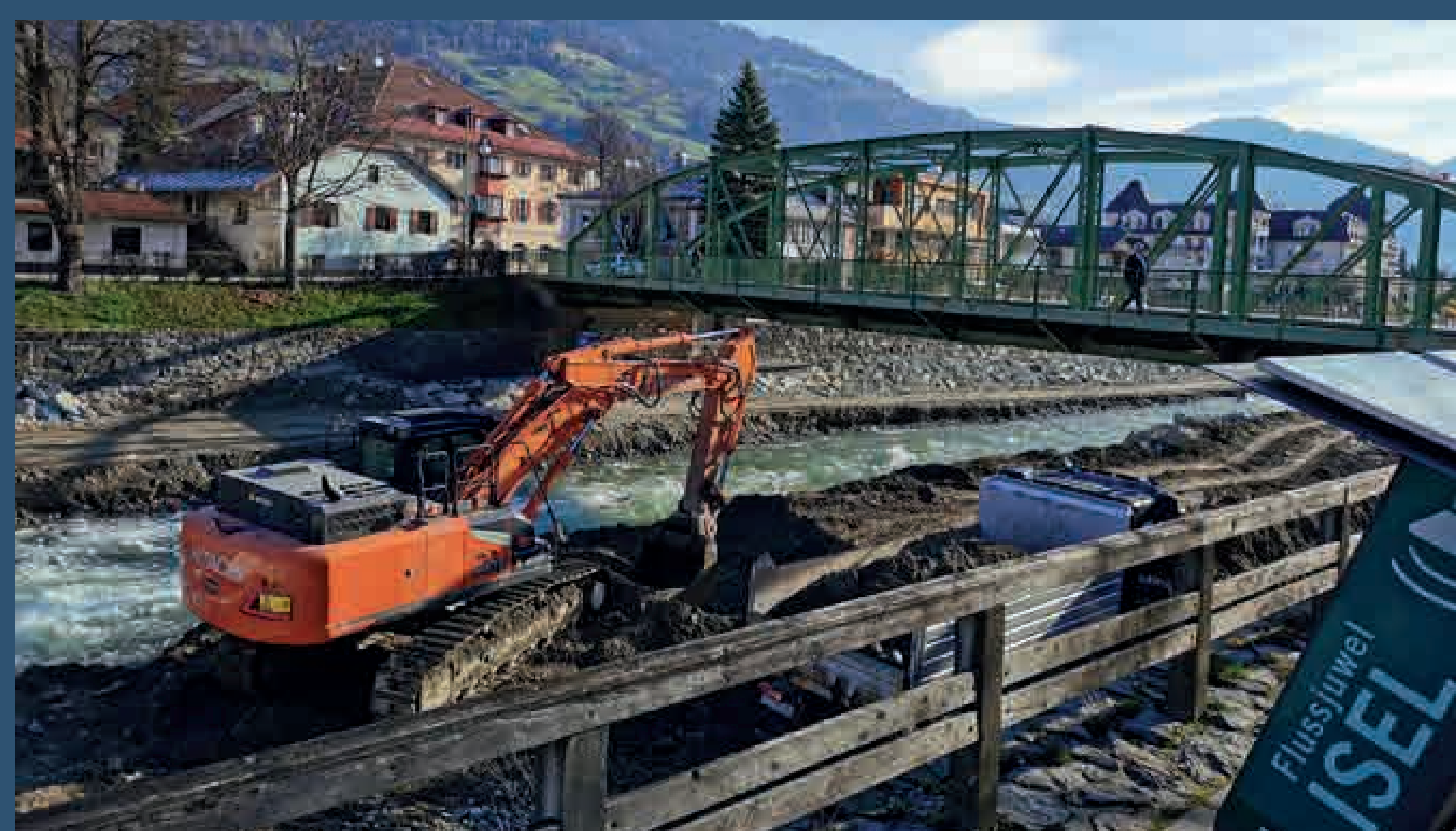
▲ Die Vorschichtung an den Bestandsmauern oberhalb der Spitalsbrücke, März/April 2024 Fotograf: Martin Koller – Sammlung TAP bzw. Philipp Brunner – Brunner Images; Stadt Lienz
