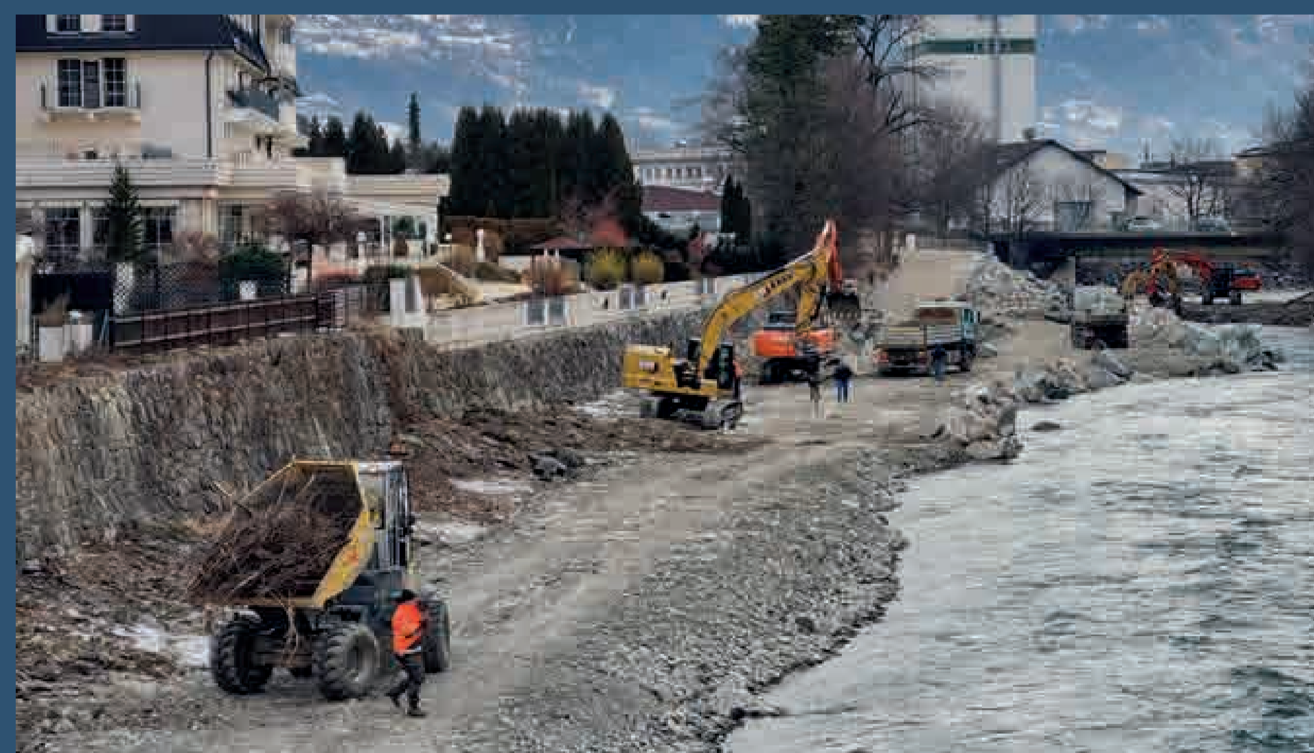
▲ Erste Arbeiten zwischen Spitalsbrücke und Hofgartenbrücke, bereits im Jänner 2024 Fotograf:in: Hedi Latzko; Sammlung Hedi Latzko – TAP
