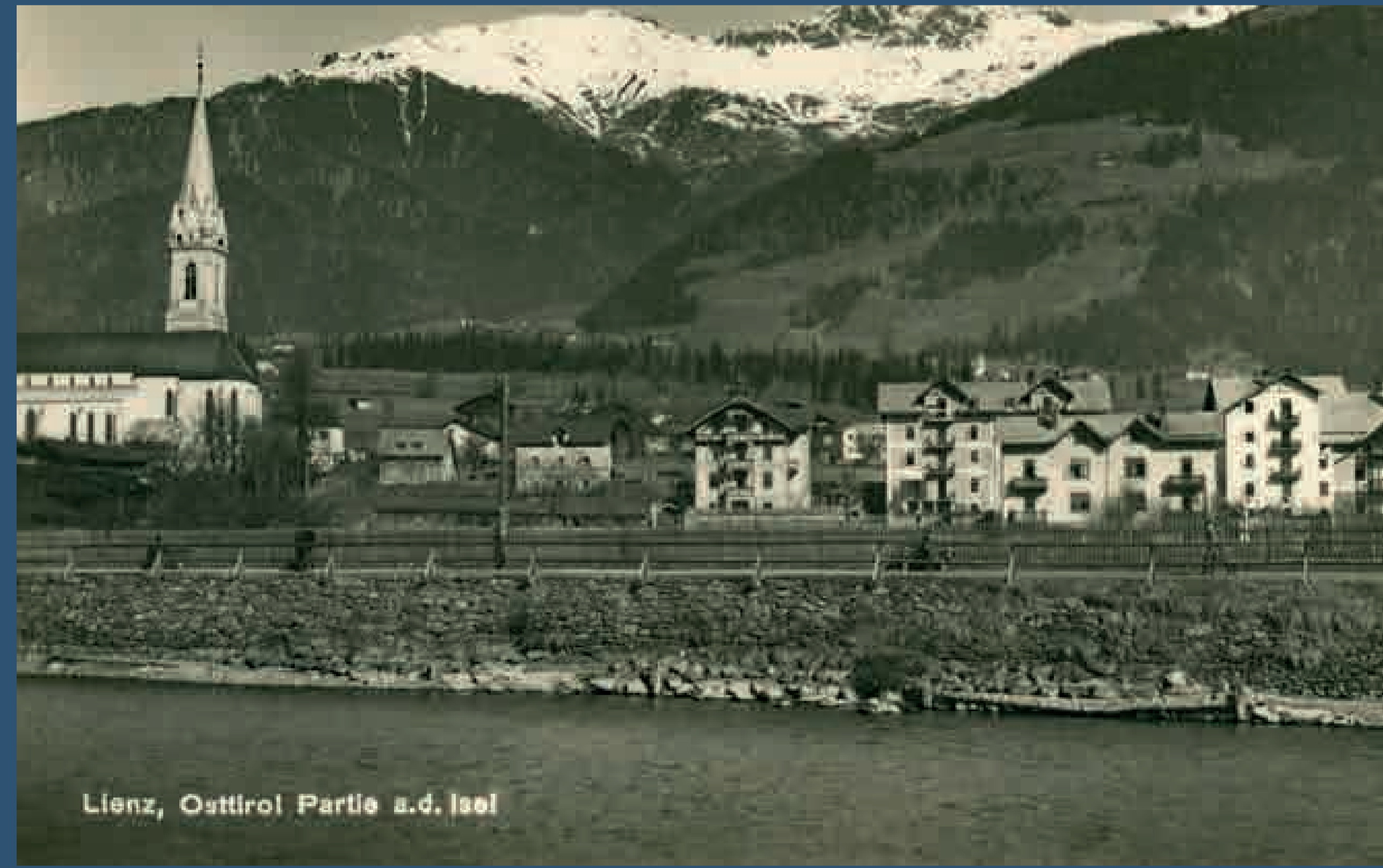
▲ Die Uferanlagen nach der Pfarrbrücke, um 1927 Fotograf: Hans Fracaro; Sammlung Stadtgemeinde Lienz, Archiv Museum Schloss Bruck – TAP
