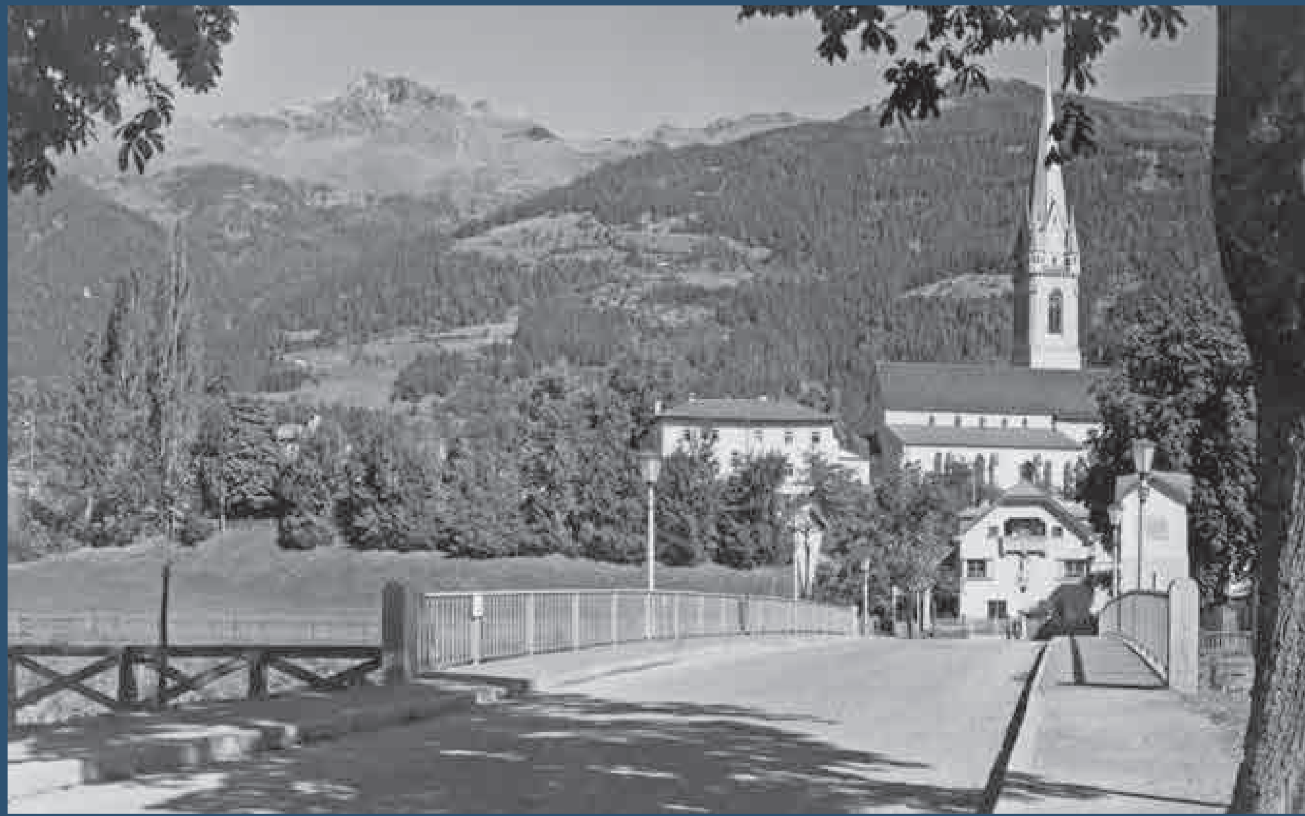
▲ Blick über die Pfarrbrücke Richtung Norden zu Schleinitz und St. Andrä, um 1955 Fotograf: Alois Baptist; Sammlung Foto Baptist – TAP
