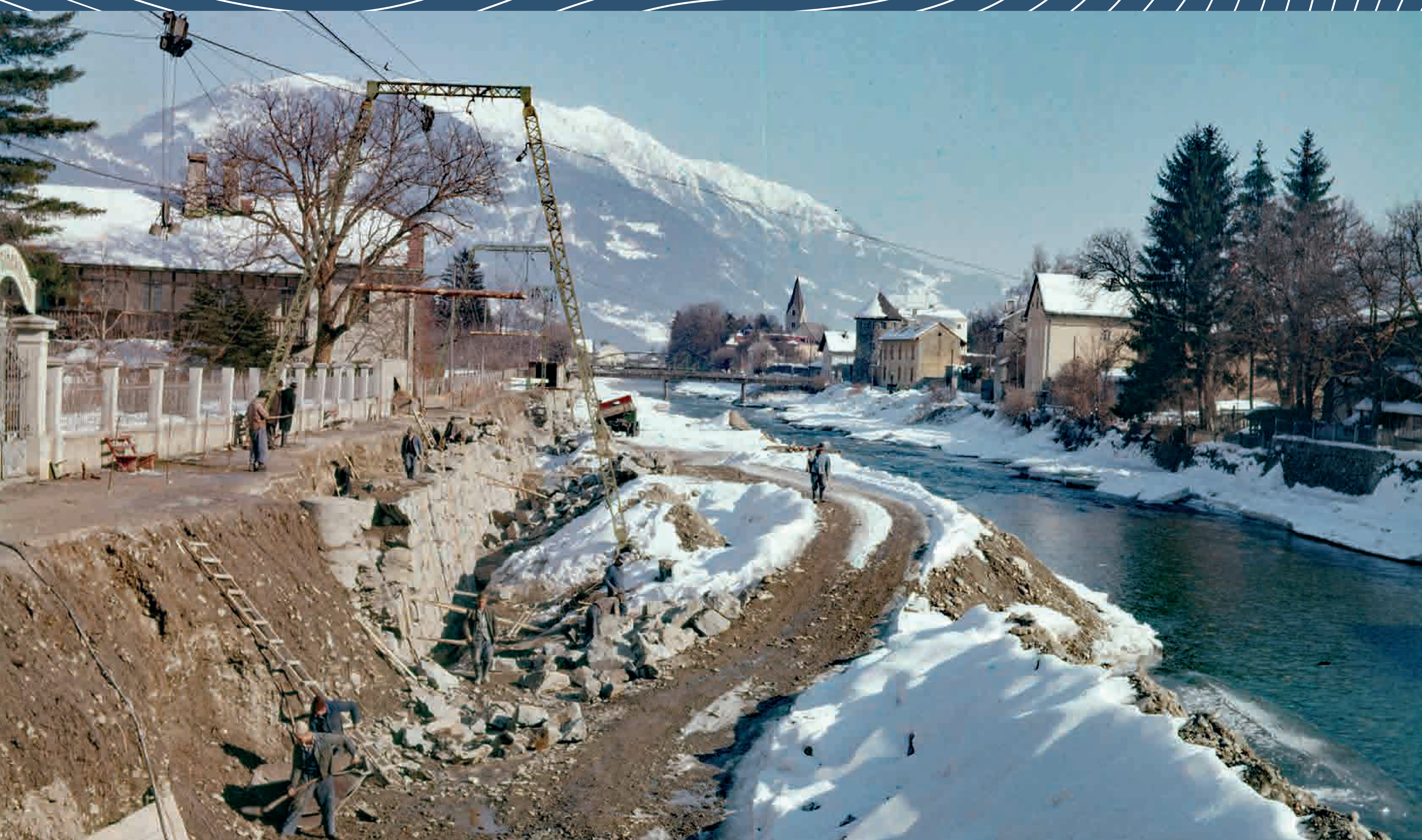
▲ Errichtung der Isel-Kaimauer, mit Materialseilbahn, 1963 Fotograf: Unbekannt – Archiv Baubezirksamt Lienz
