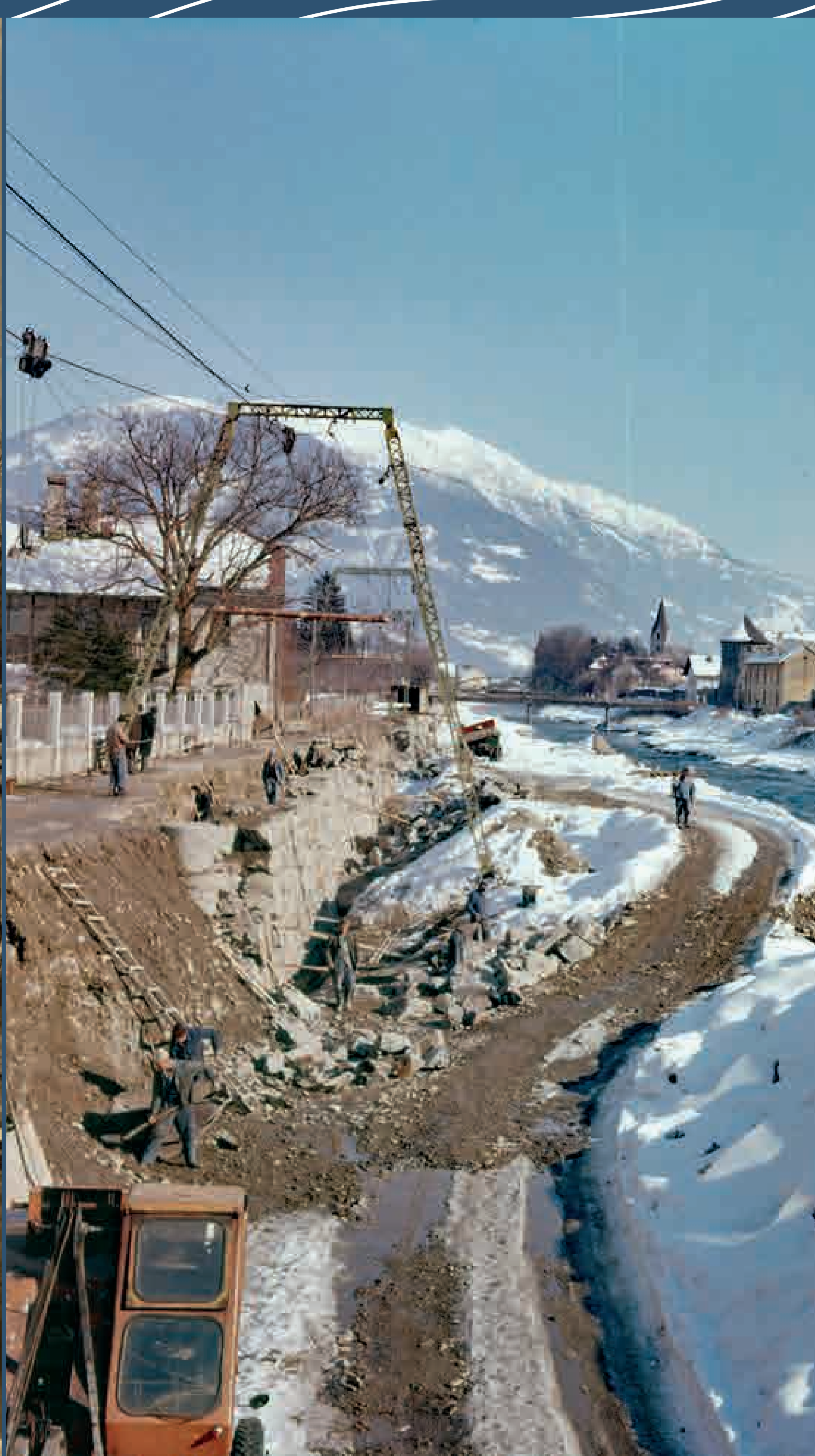
▲ Errichtung der Isel-Kaimauer, mit Materialsellbahn, 1963 Fotograf: Unbekannt – Archiv Baubezirksamt Lienz
