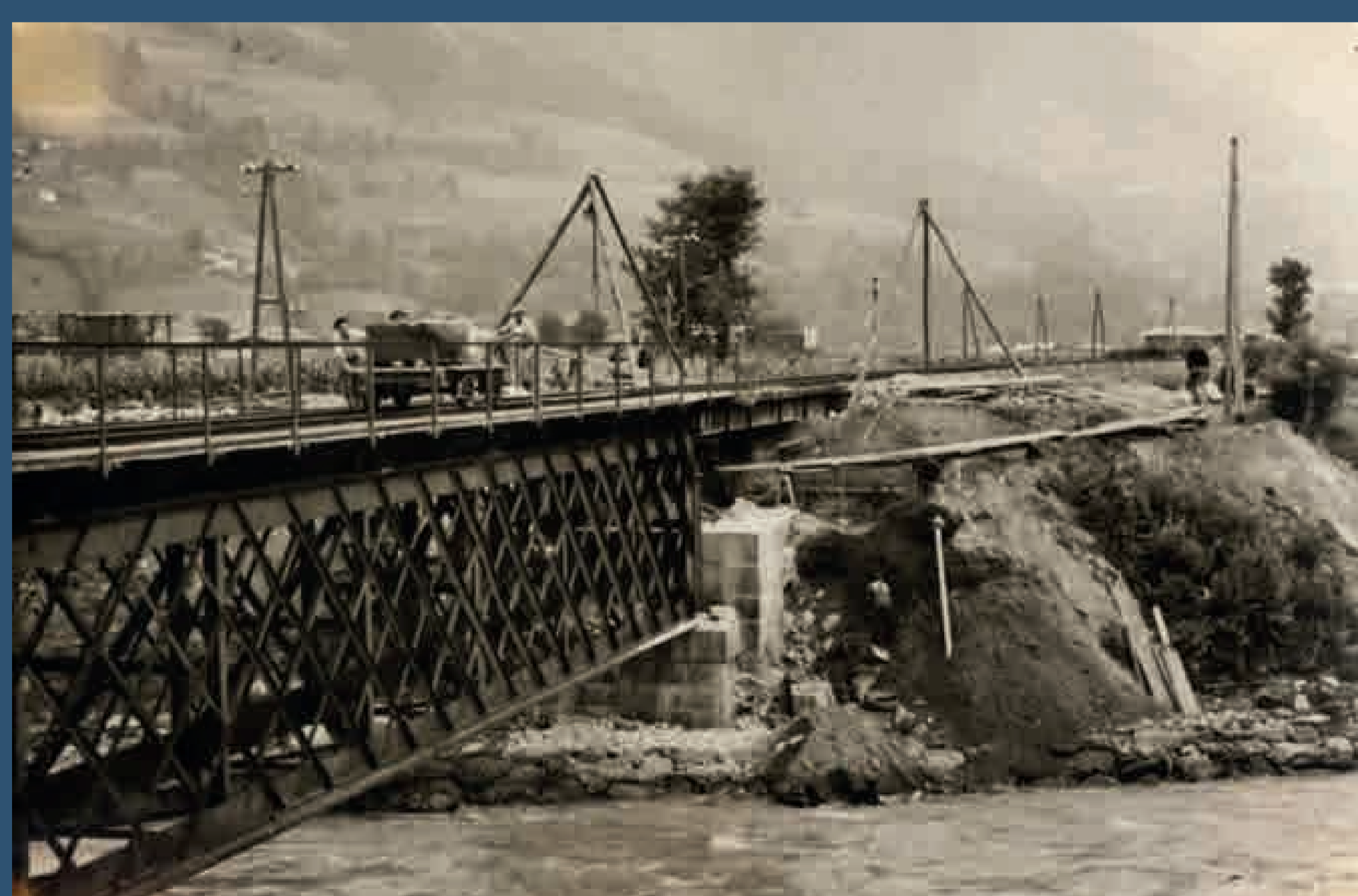
▲ Abtragung der alten Widerlager, 1948 bzw. die wieder stabilisierte Eisenbahnbrücke, um 1955 Fotograf: Unbekannt; Sammlung Eisenbahnfreunde Lienz bzw. Sammlung TAP
