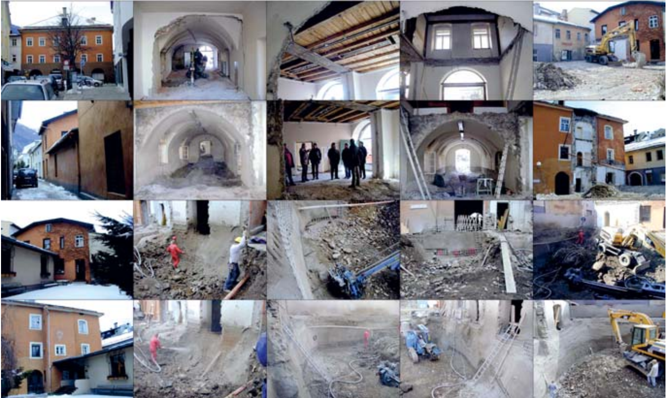
Die Umbauarbeiten im Alten Rathaus schreiten zügig voran.
